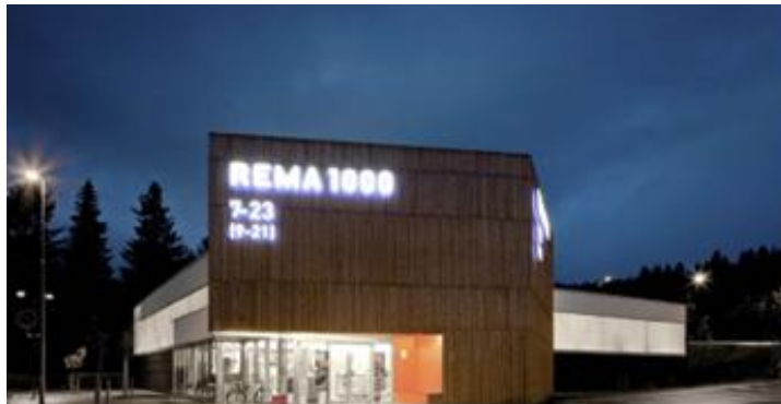
Figur 3-4:REMA 1000 Kroppanmarka i Tiller, en av de første dagligvarebutikkene som ble bygd med system for kulde- og varmeproduksjon som bruker CO 2 som kuldemedium. Foto: REMA 1000 Norge
